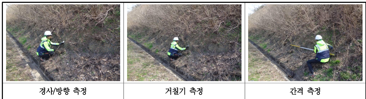
【사진 1.3.3】 1구간 불연속면 측정 현황
